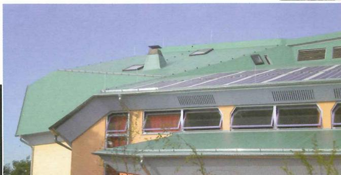
Dank integrierter Solarmodule konnte die besondere Architektur des Daches erhalten bleiben.
